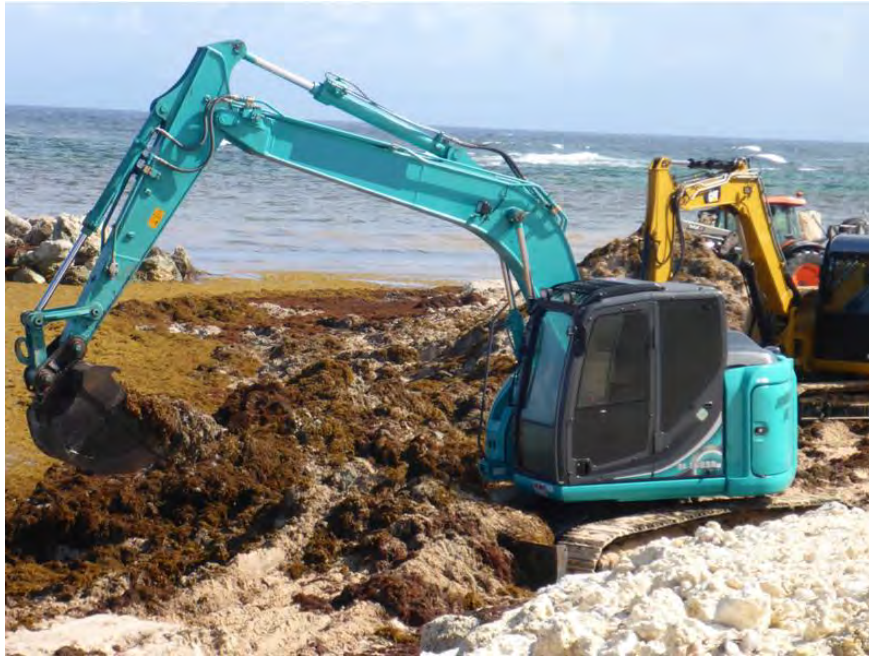
Figure 8: Opération de ramassage effectuée par une pelleuse (Site web, expertise Cedre).
