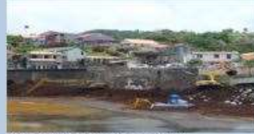
Pelle mécanique à long bras
