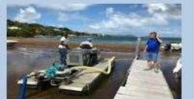
Pompage via porte outil amphibie
