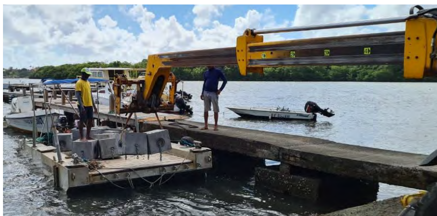
Figure 21 : Chargement de blocs béton en vue de leur installation sur le barrage de Cap Est (Source : FILET DROM)
