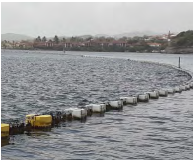
Figure 13 : Vue du barrage de Cap Est en août 2019 (à gauche) et état de décomposition des flotteurs polystyrène entre juin et septembre 2018 (à droite) (Source : SUEZ CONSULTING)
