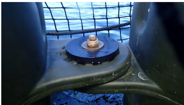
Figure 38 : Ancien système d'accroche corrodé (à gauche) en cours de remplacement (à droite) (Source : SUEZ CONSULTING)
