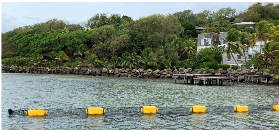
Figure 11 : Vue sur le barrage de 150 m pour protéger le littoral de l'hôtel du Domaine des Fonds Blancs (Cap Est) en Avril 2021 (Source : SUEZ CONSULTING)
