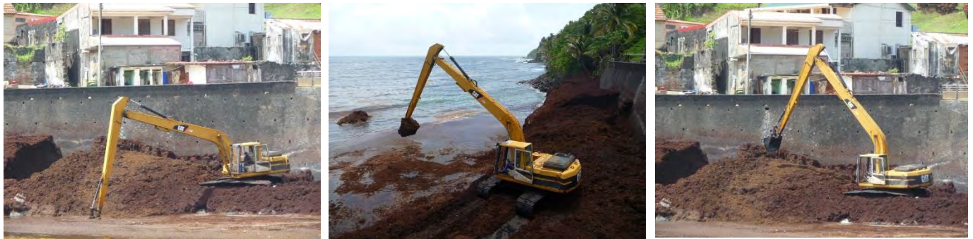
Figure 6: séquence de ramassage avec une pelle long bras
