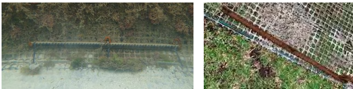
Figure 20 : Barres de fer assurant le lestage du filet (Source : SUEZ CONSULTING)
