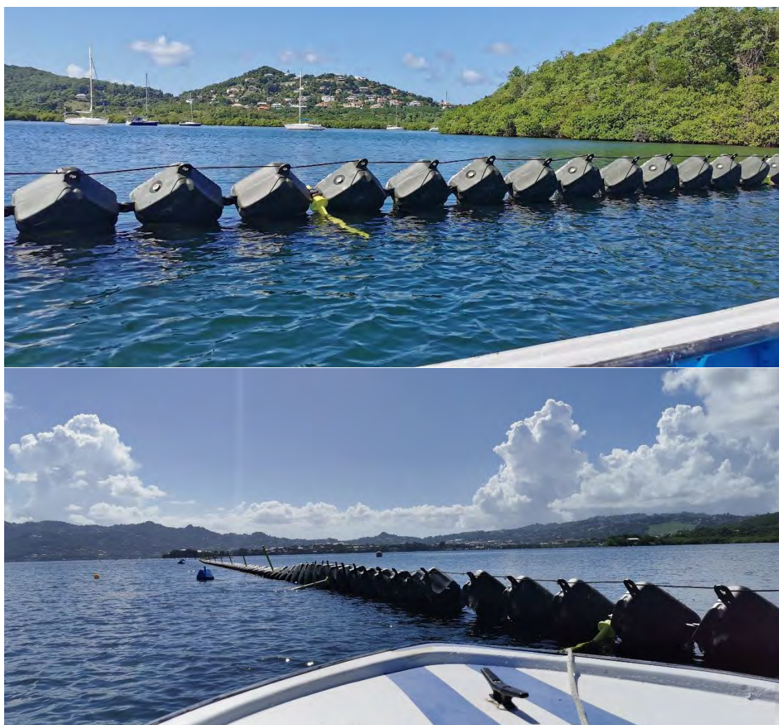
Figure 35 : Illustration du barrage de Pointe Lynch complètement basculé par le poids des huitres (Source : SUEZ CONSULTING)
