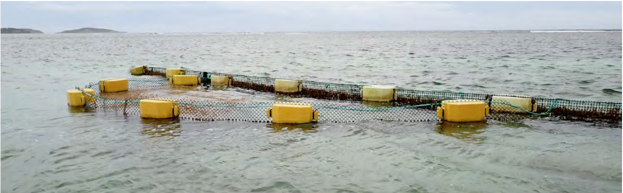
Figure 25 : Passe aménagée sur le barrage du Cap Est (Source : SUEZ CONSUTLING)
