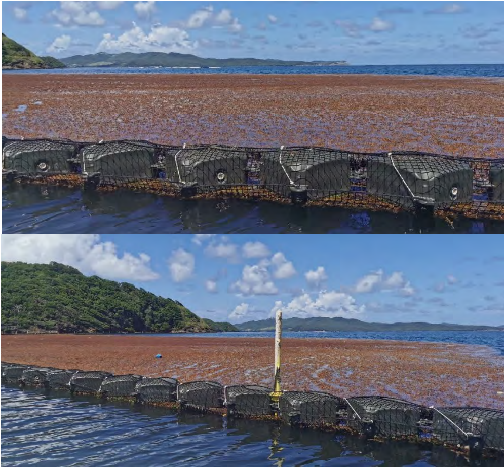
Figure 37 : Positionnement des filets en Y autour des CUBI sur le barrage de Baie Cayol (Source : SUEZ CONSULTING)
